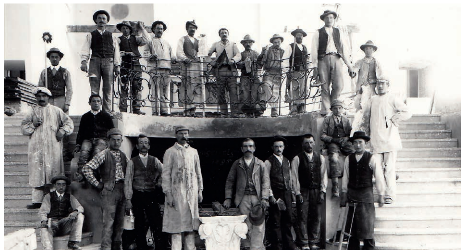
Arbeiter – es dürfte sich dabei um Italiener gehandelt haben – beim Bau der Hardegger-Kirche im Innern des Klosters im Jahr 1898. Die Kirche wird heute als Museum genutzt.
